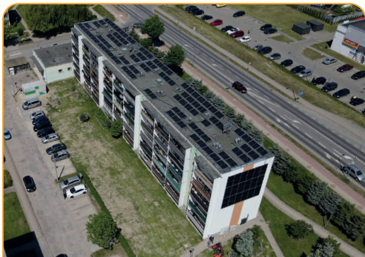
Bartoszyce ul. Bema 53 zainstalowana moc 108 kW, ogrzewa 2 400 m 2
