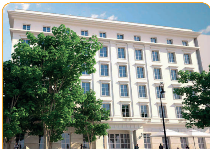
Warszawa - Akademik zainstalowana moc 200 kW, ogrzewa 5 000 m 2
