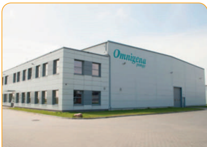
Święcice - Siedziba firmy Omnigena zainstalowana moc 400 kW, ogrzewa 8 000 m 2
