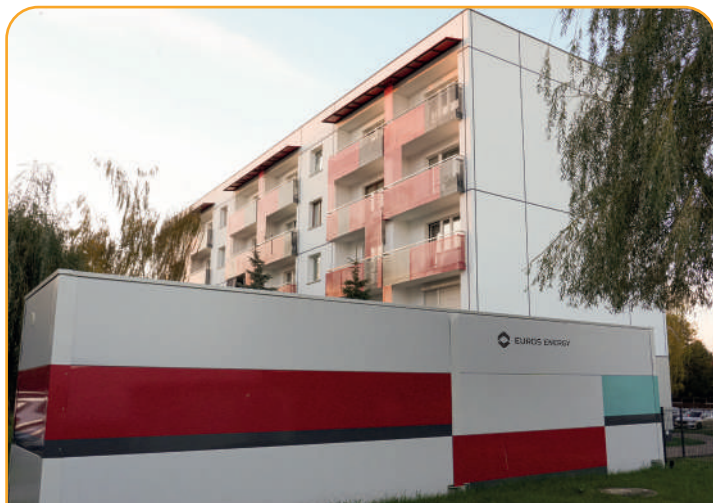
Zwoleń ul. Wojska Polskiego 15 zainstalowana moc 100 kW, ogrzewa 2 100 m 2
