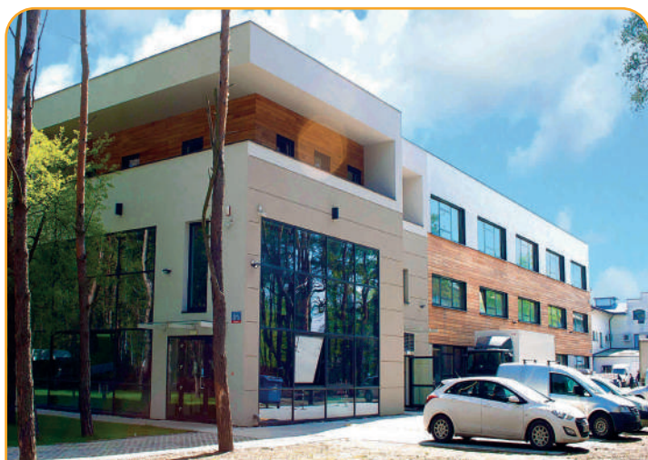
Józefów - Biura/fabryka kosmetyków zainstalowana moc 600 kW, ogrzewa 3 500 m 2
