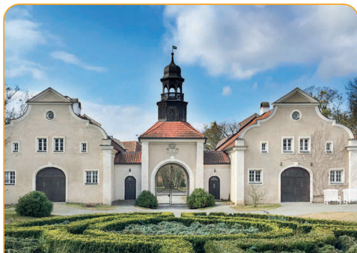
Bartoszyce - Pałac Galiny zainstalowana moc 200 kW, ogrzewa 10 000 m 2
