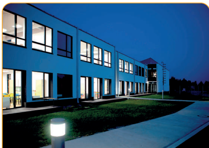
Chotomów - Szkoła zainstalowana moc 200 kW, ogrzewa 5 000 m 2
