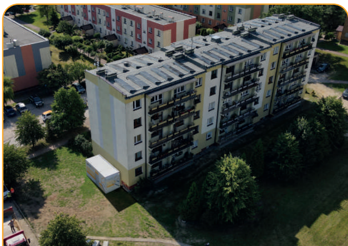
Przysucha ul. Hubala 45 zainstalowana moc 100 kW, ogrzewa 1 750 m 2
