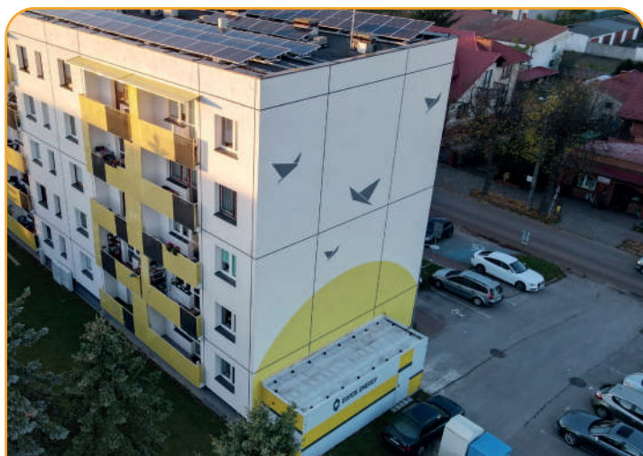
Zwoleń ul. Bogusza 9/11 zainstalowana moc 180 kW, ogrzewa 3 500 m 2
